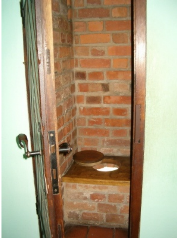
Ustęp w średniowiecznym zamku w Darłowie. Mieści się na drugim piętrze już poza ścianą budynku.
